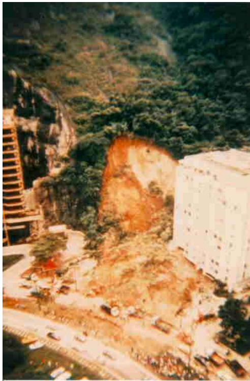
Figura 6.19 - Ruptura em encosta Av Epitácio Pessoa, 1988
