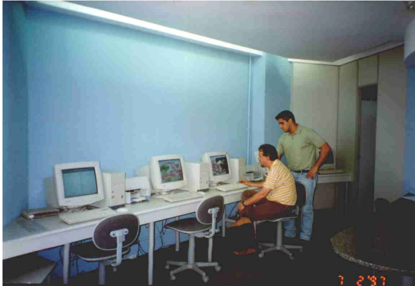
Figura 6.21 - Sala de controle do Alerta-Rio
