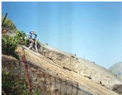
Figura 2.10 - Juntas de alívio e formação de lascas
