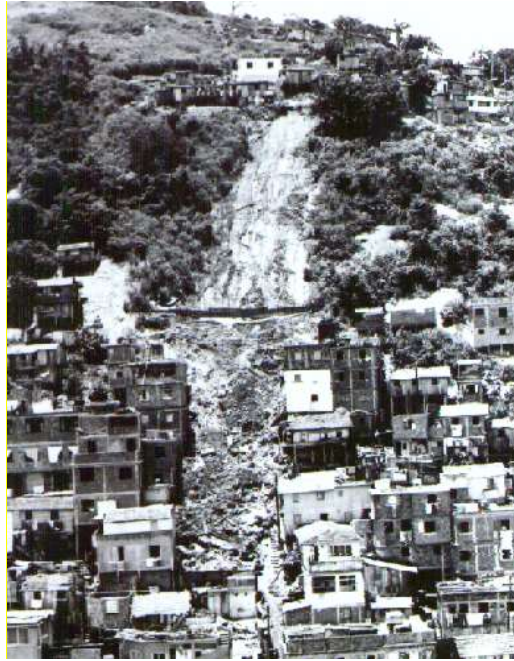
Figura 3.4 - Corridas de Solo Residual e lixo - Pavão-Pavãozinho, 1983 (foto Geo Rio)
