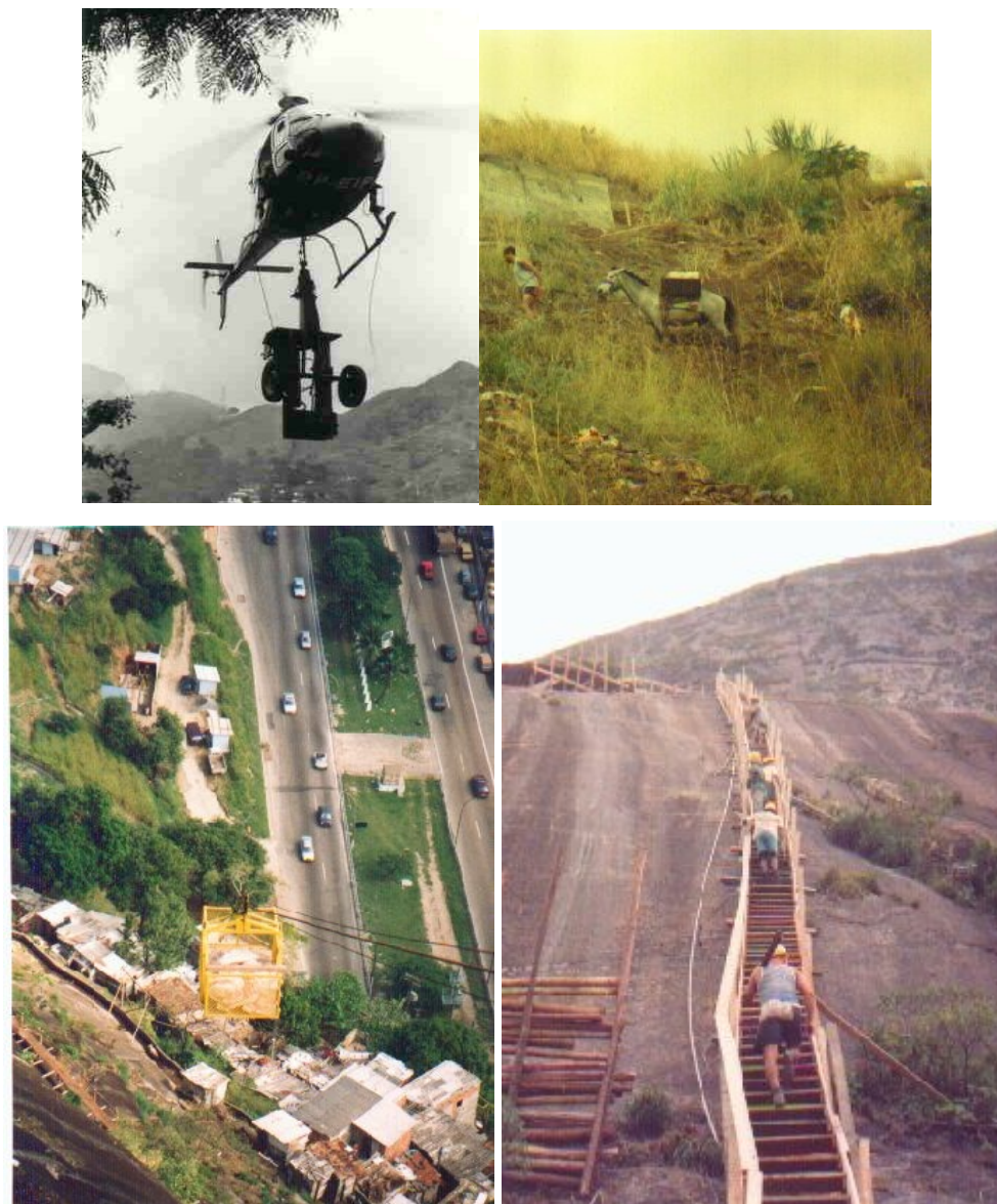
Figura 5.5 - Transporte de equipamentos para locais de difícil acesso: transporte com helicóptero, mulas, teleférico e trabalhadores (Fotos GeoRio)
