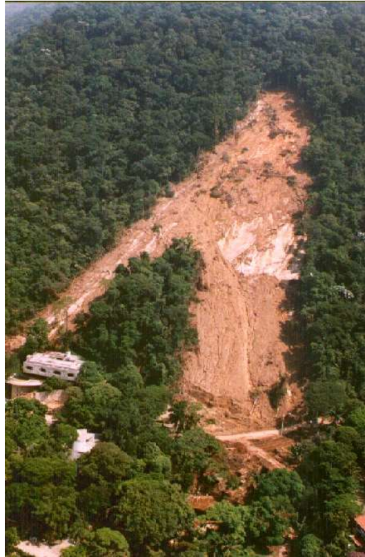
Figura 3.3 - Deslizamento de solo residual - São Conrado, 1996 (foto Geo Rio)
