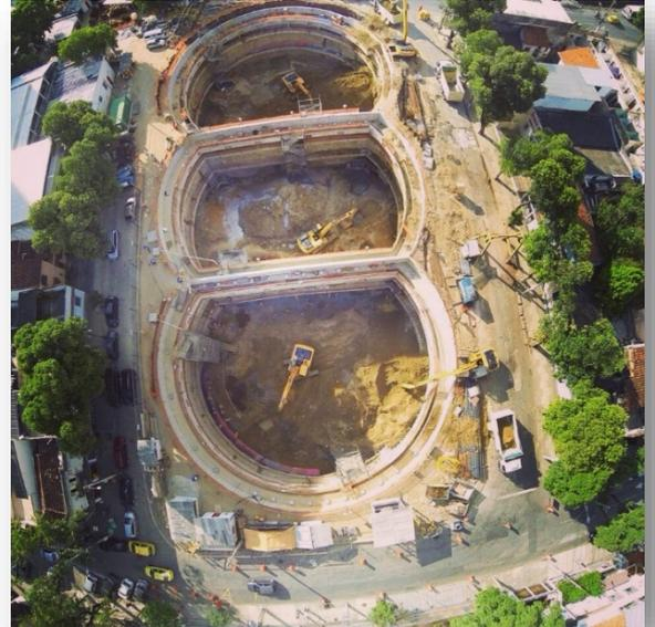
A Engesis projetou vigas internas de suporte em vários níveis e tratamento com colunas de jet grouting na região dos encontros entre círculos, de forma a permitir a concretagem desses nós com concreto moldado in loco.
