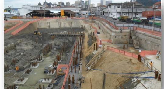
**Descrição:** Engesis projetou a contenção de uma escavação com parede diafragma de 400 mm e 25 m de profundidade para uma escavação de 8 m em areia e argila mole de Santos com ancoragens provisórias. O terreno consta de uma camada de areia fofa seguida de 8 m de argila mole.
