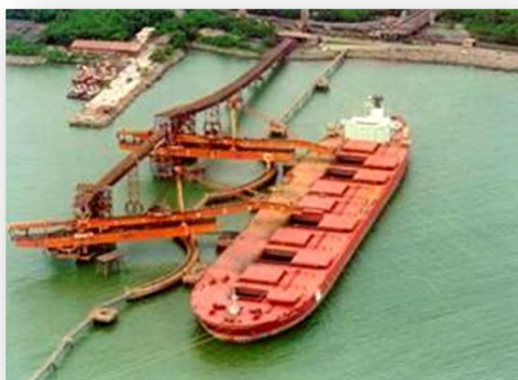
Pier 2, Porto de Tubarão
