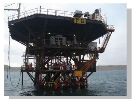
Estrutura offshore, Talara, Peru
