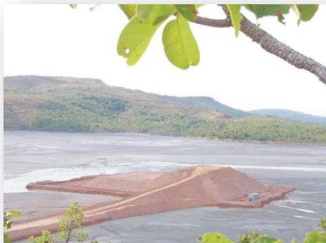
Aterro experimental sobre rejeitos
