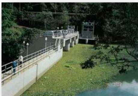
Barragem Areal 30 MW
