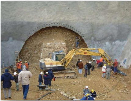
Túnel Cerrillos, Bolívia
