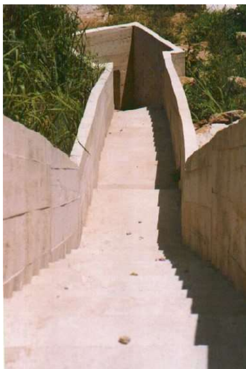
Figura 2.10 - Canaleta longitudinal de descida (GeoRio)
