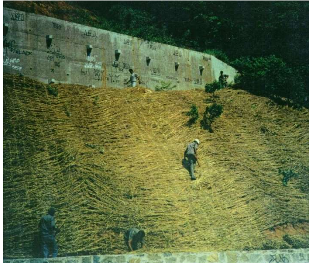
Figura 2.25 - Aplicação da tela vegetal (GeoRio)
