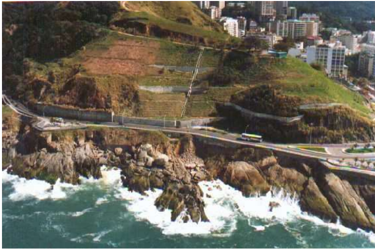
Figura 2.3 - Sistema de drenagem superficial de talude
