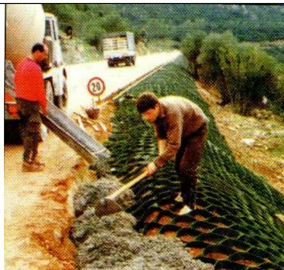
Figura 2.33 - Instalação de geocélula em talude (MacGuide, 1999)
