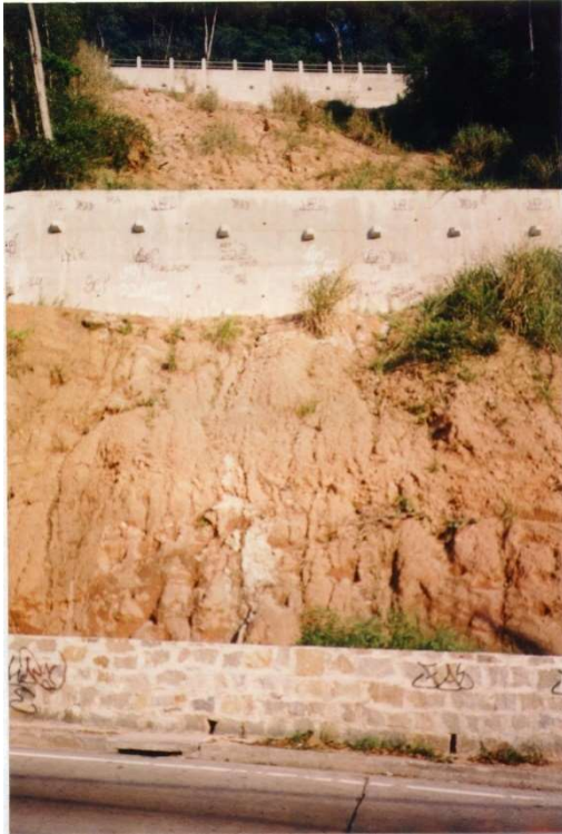
Figura 2.24 - Vista inicial do talude (GeoRio)
