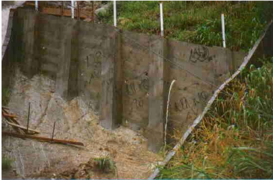
Figura 2.45 - Muro com contrafortes
