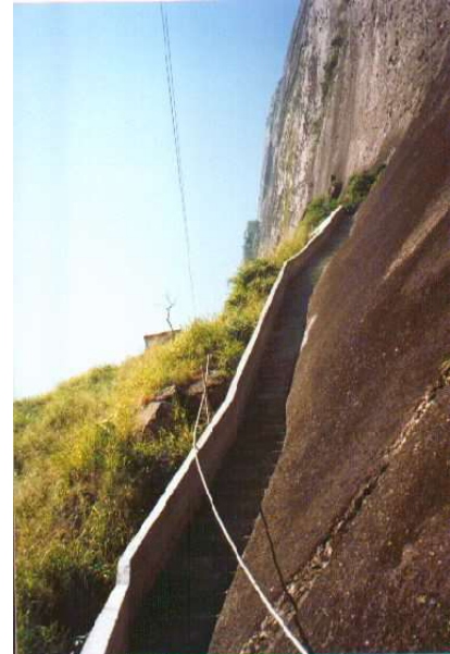
Figura 2.4 - Canaleta chumbada em rocha no contato com Talus/Colúvio
