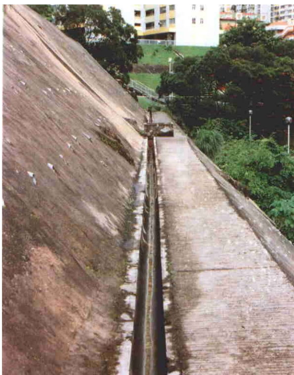
Figura 2.9 - Canaleta transversal com seção circular (GEO, 1995)
