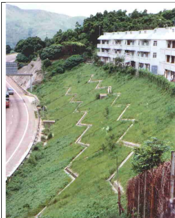
Figura 2.20 - Cobertura vegetal com canaletas de drenagem (GEO, 1995)
