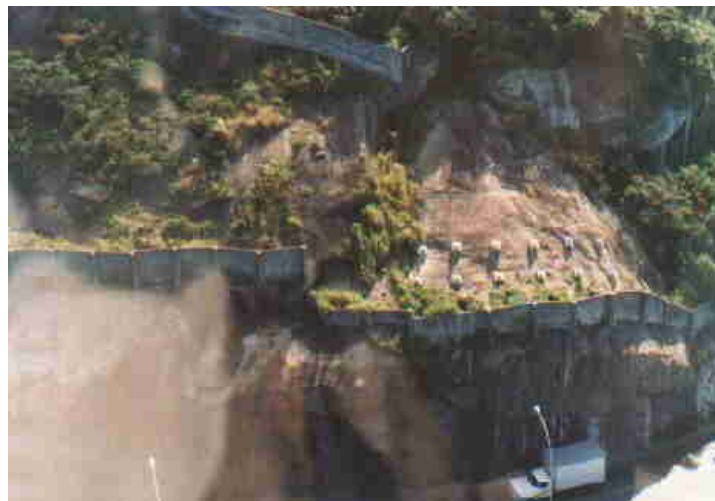
Figura 2.5 - Canaleta chumbada na rocha
