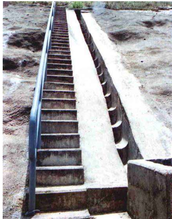
Figura 2.13 - Escada de acesso (GEO, 1995)
