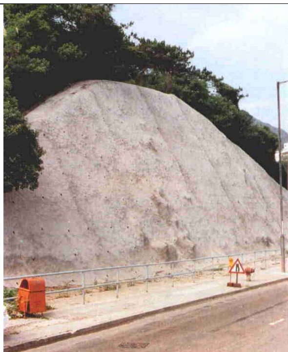
Figura 2.21 - Cobertura com concreto projetado (GEO, 1995)
