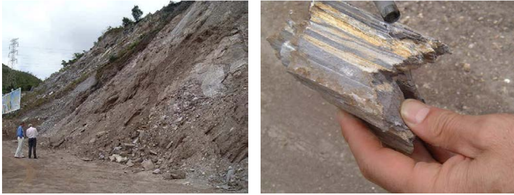
Fig. 8.5. (a) Talude em filito, Minas Gerais; (b) Planos de menor resistência ao longo das juntas
