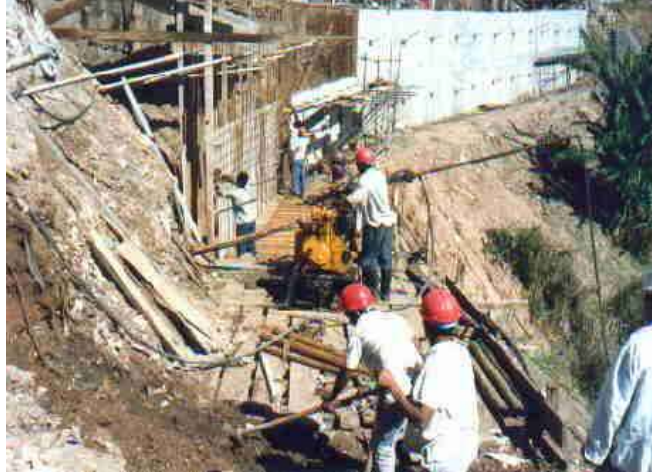
Figura 3.2 - Fases de execução de uma cortina (Foto GeoRio)
