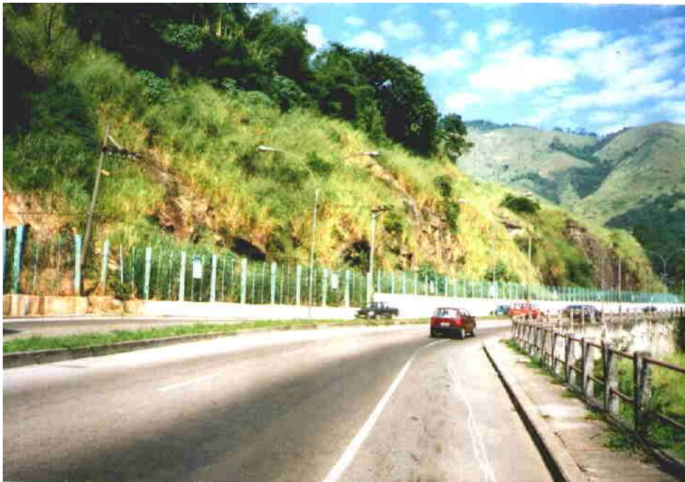
Figura 5.17 - Cerca flexível implantada na Estrada Grajaú-Jacarepaguá
