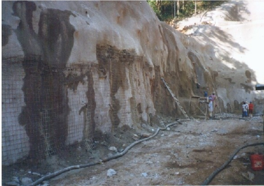
Figura 4.5 - Execução do concreto projetado (Linha Amarela, RJ)
