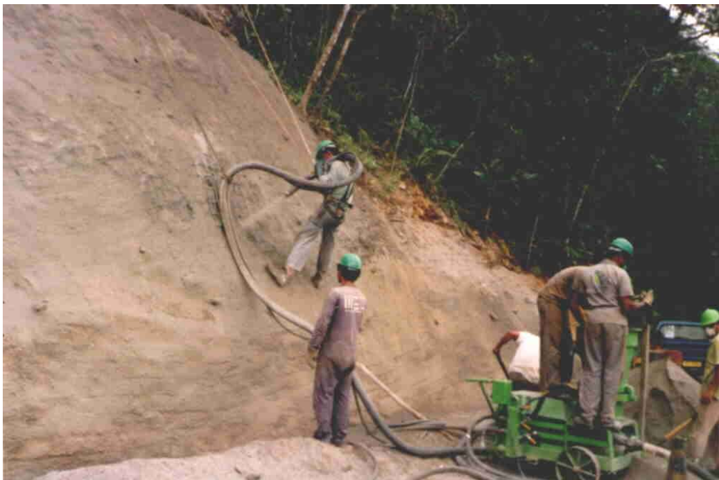
Figura 6.5 - Concreto projetado em talude (Foto Genco)
