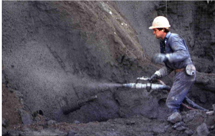
Figura 5.13 - Concreto projetado para proteção de talude rochoso
