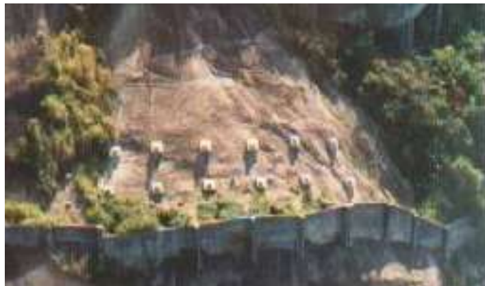
Figura 5.4 - Uso de chumbadores para fixação de lasca
