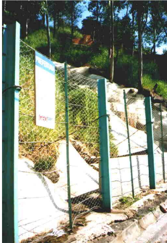
Figura 5.18 - Detalhe da cerca flexível
