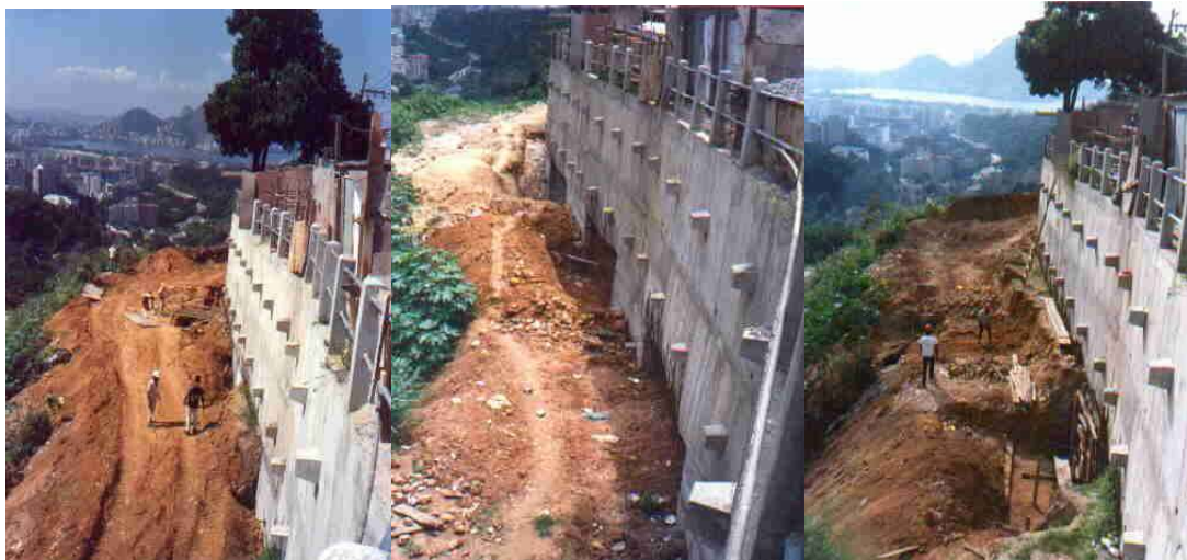
Figura 3.5 - Escavação em nichos
