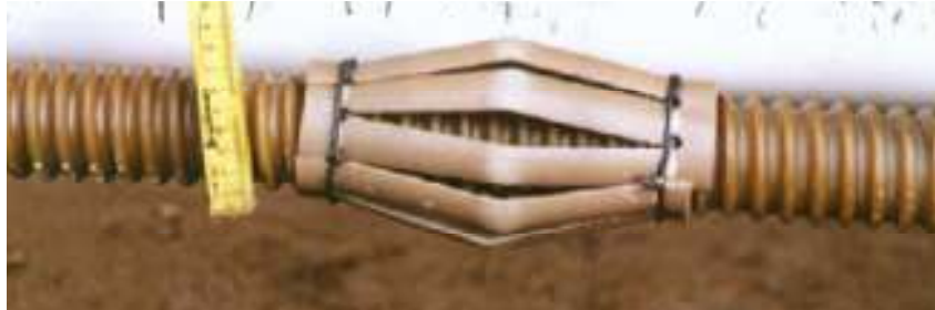
Figura 2.2 - Trecho ancorado: centralizador e tubo corrugado de proteção (Foto Este Engenharia)
