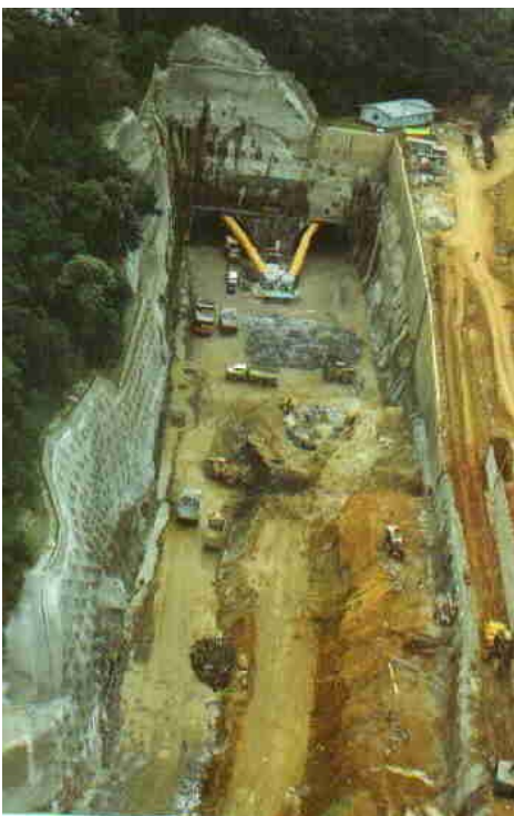
Figura 4.18 - Contenções no emboque do Túnel da Covanca, Linha Amarela, solo grampeado à esquerda
