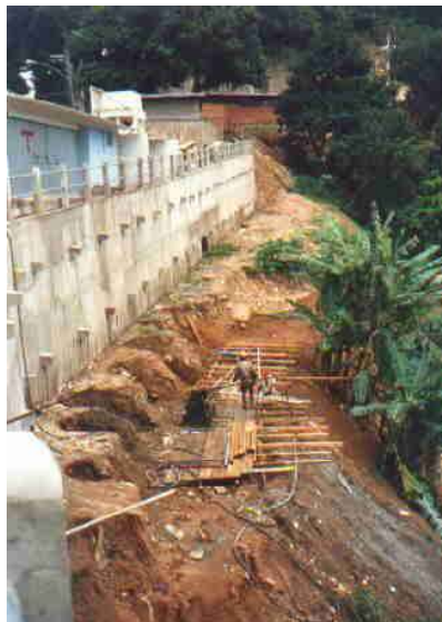
Figura 3.3 - Escavação em nichos
