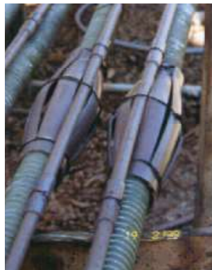
Figura 2.3 - Tubo de injeção com válvulas manometre (Foto Este Engenharia)
